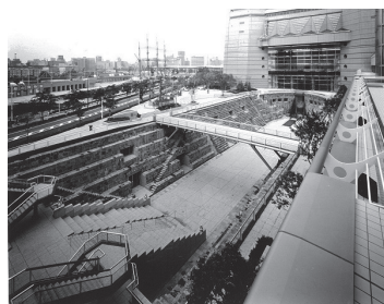
ドックヤードガーデン (横浜ランドマークタワー)
